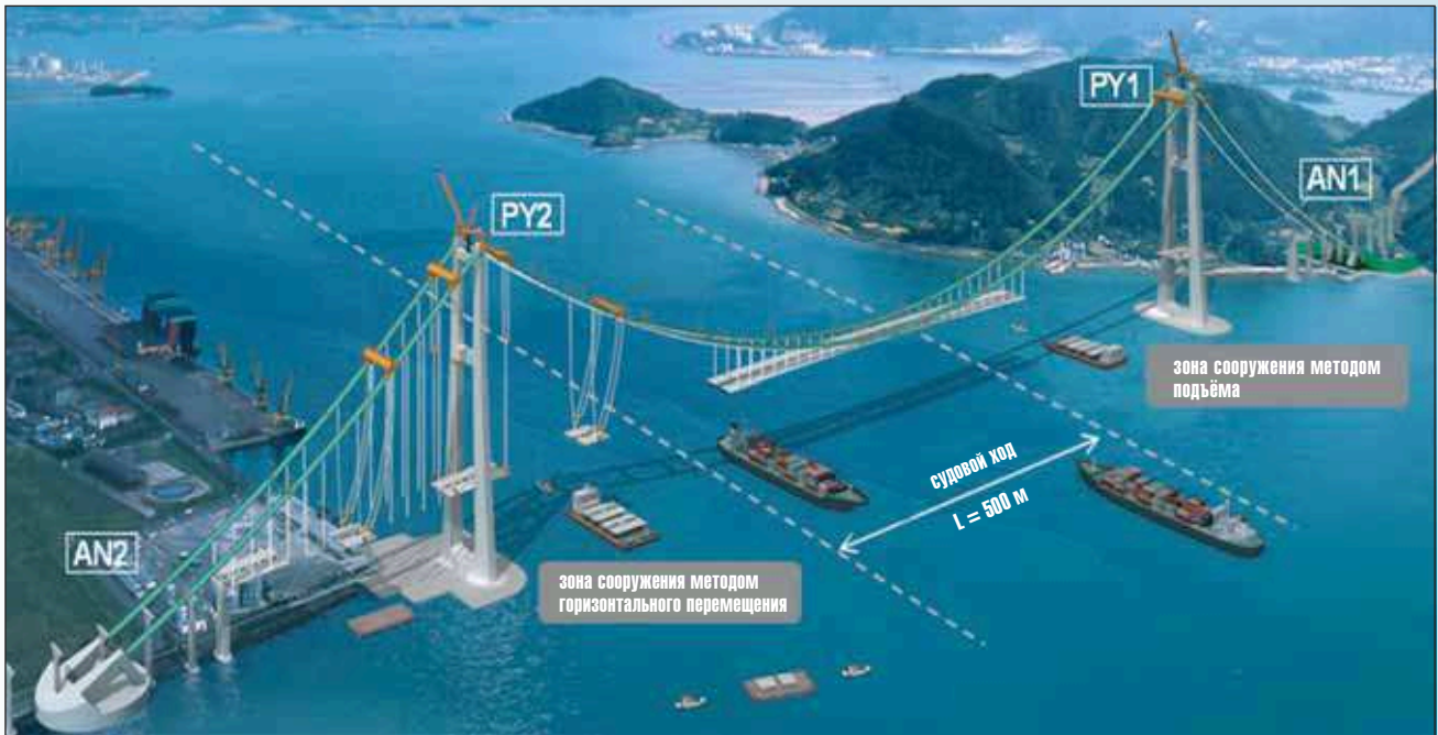
Рис. 13. Монтаж блоков балки жесткости методом горизонтальной подачи с оставлением свободного прохода судов
