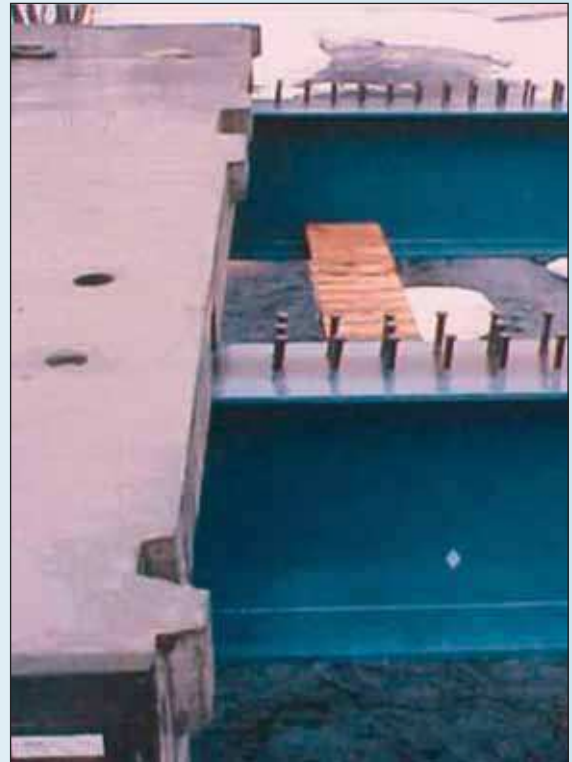
Рис. 13. Сборная плита с сухим стыком
