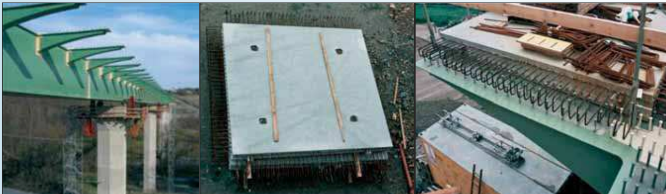
Рис. 8. Виадук Бареталь со сборной железобетонной плитой, изготовленной на заводе на полную высоту
