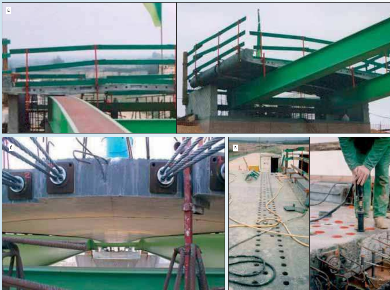
Рис. 9. Монтаж пролетного строения системы VINCI: а – плиты монтируют на балки, не имеющие упоров; б – плиты подвергают предварительному обжатию; в – гибкие штыревые упоры приваривают к верхнему поясу балки через отверстия в плите
