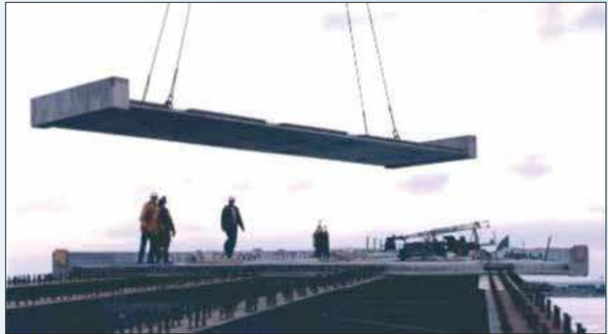
Рис. 10. Монтаж блоков плиты на мосту Уэксфорд
