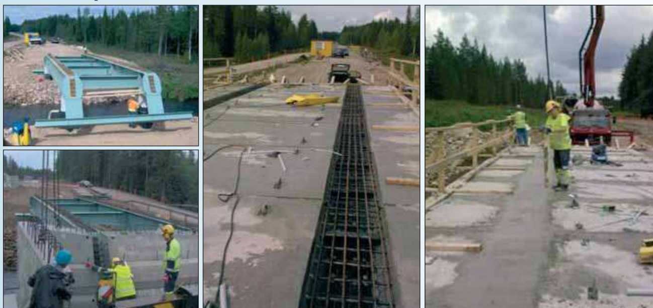
Рис. 12. Этапы строительства моста Лайзенцианоки
