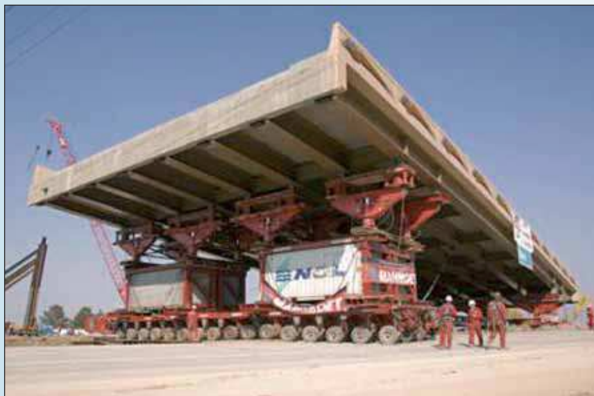
Рис. 3. Перевозка пролетного строения путепровода на трассе Юг 4500 механизмом SPMT, шт. Юта
