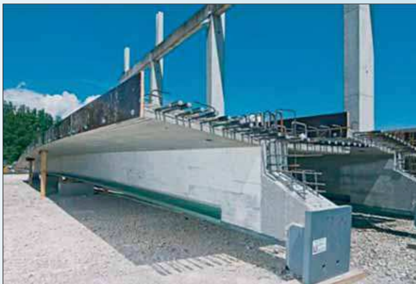
Рис. 7. Сборная балка пролетного строения системы VFT заводского изготовления
